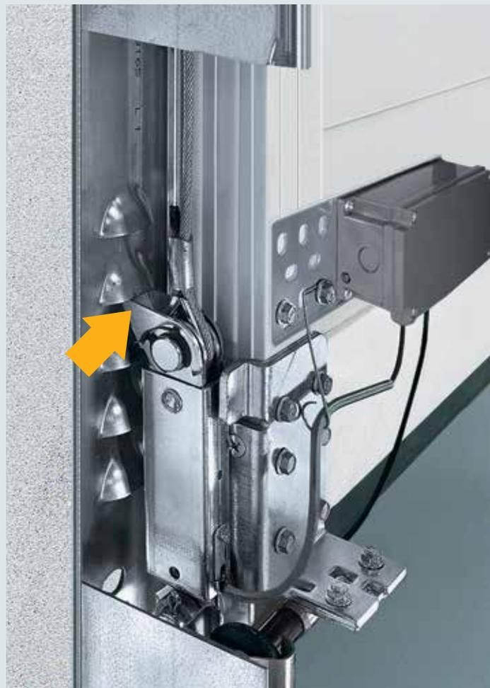
En cas de soulèvement de la porte, le crochet de verrouillage de la sécurité anti-relevage s'enclenche automatiquement.
